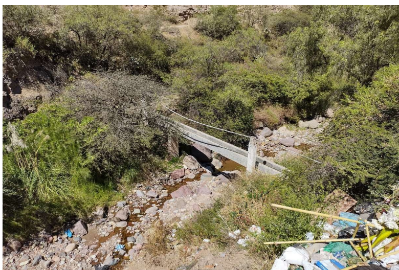
FIGURA N°03: TRAMO CRÍTICO EN EL RÍO PAQUECC , VISTA DE LAS OBRAS HIDRAULICAS, PASE AEREO DEL SISTEMA DE RIEGO PAQUECC, CONSTA DE MATERIAL CONCRETO ARMADO.
